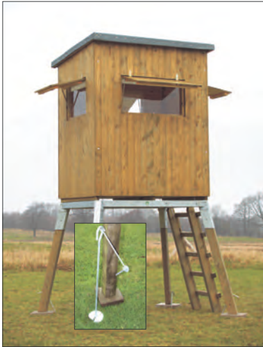
Bockgerüst mit konischen Eckpfosten und Erdanker
