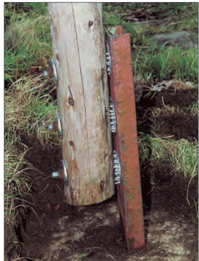
Einbetonierte Winkelleisen
