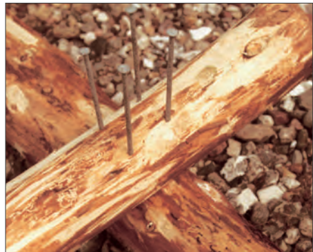
Knotenpunkt genagelt mit 4 Nägeln 4,2/120 je Anschluss
